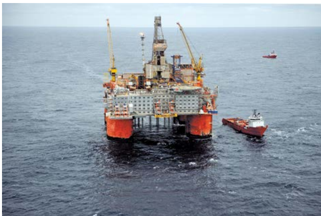
Snorre A-plattformen, som kom i produksjon i 1992, er en integrert bore-, prosesserings- og boligplattform som også prosesserer olje fra undervannsinnetninger på feltet og olje fra Vigdisfeltet. Transportløsningen er knyttet opp mot Statfjord-feltet. Produksjonen på Snorre B-plattformen startet i 2001. Snorre har betydelige gjenværende ressurser.
