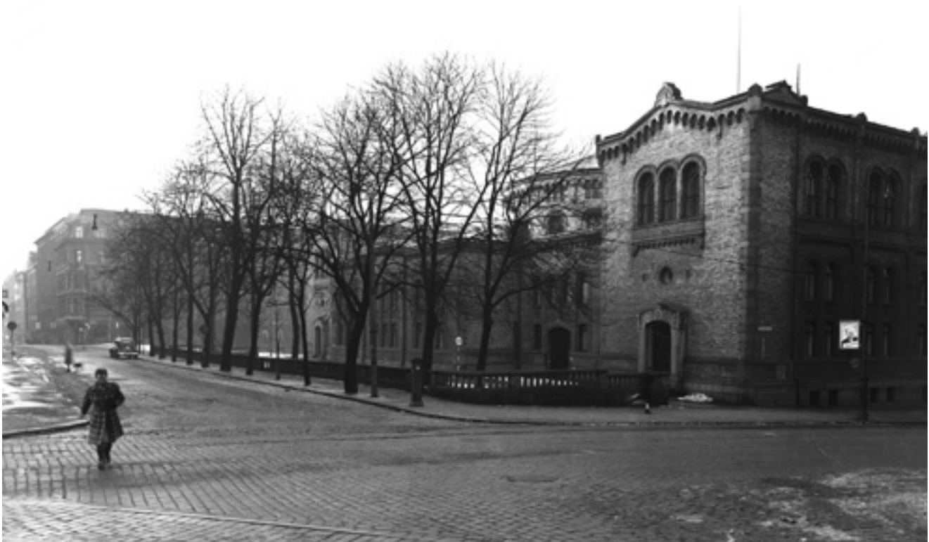
Fram til 1949 heldt Riksarkivet til i den låge bygningen ut mot Akersgata. Bygningen vart riven i 1951. (Foto: Stortingsarkivet)
