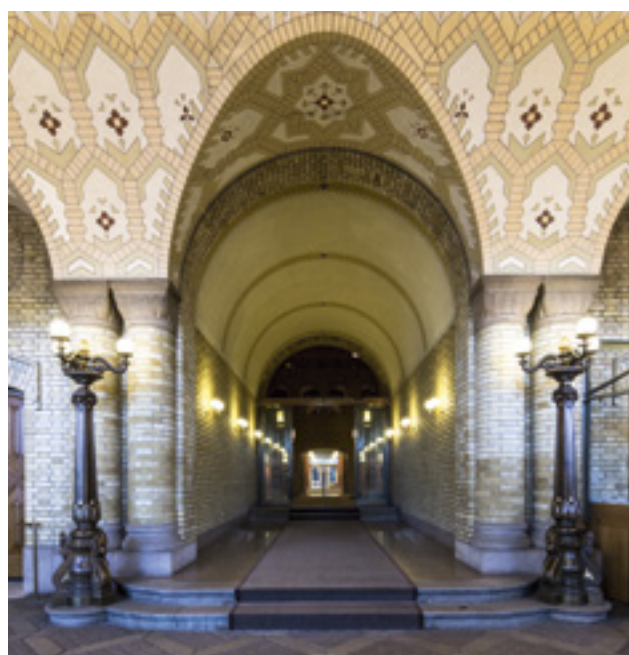
Etter ombygningene var det bare to trinn igjen av den gamle trappen. (Foto: Hans Kristian Thorbjørnsen)
