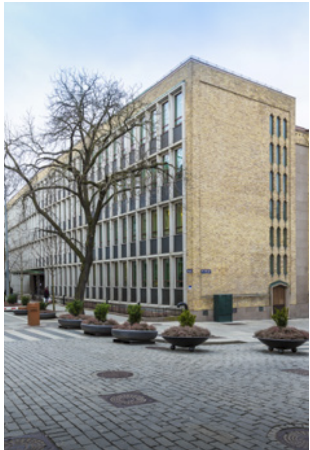
Tilbygget ut mot Akersgata stod ferdig i 1958 med en fasade av lys granitt, blankpolert sort labradorsten og gul teglsten. (Foto: Hans Kristian Thorbjørnsen)
